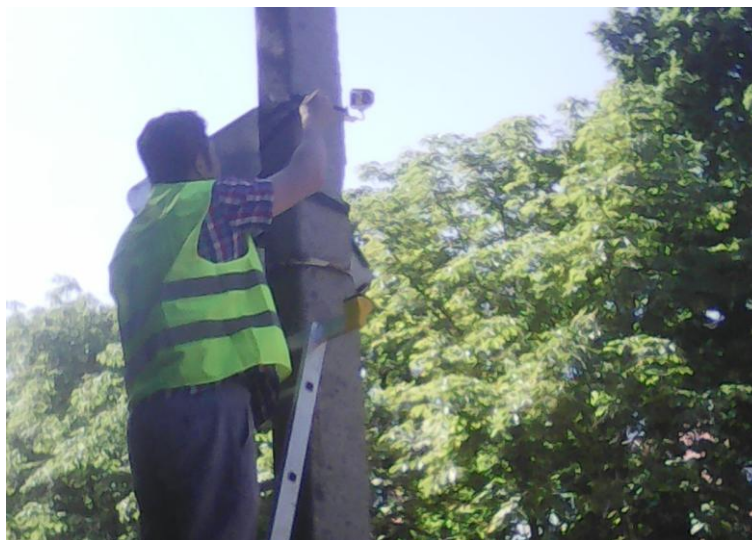
Рисунок 1 – Монтаж видеокамеры на столб линии электроосвещения
