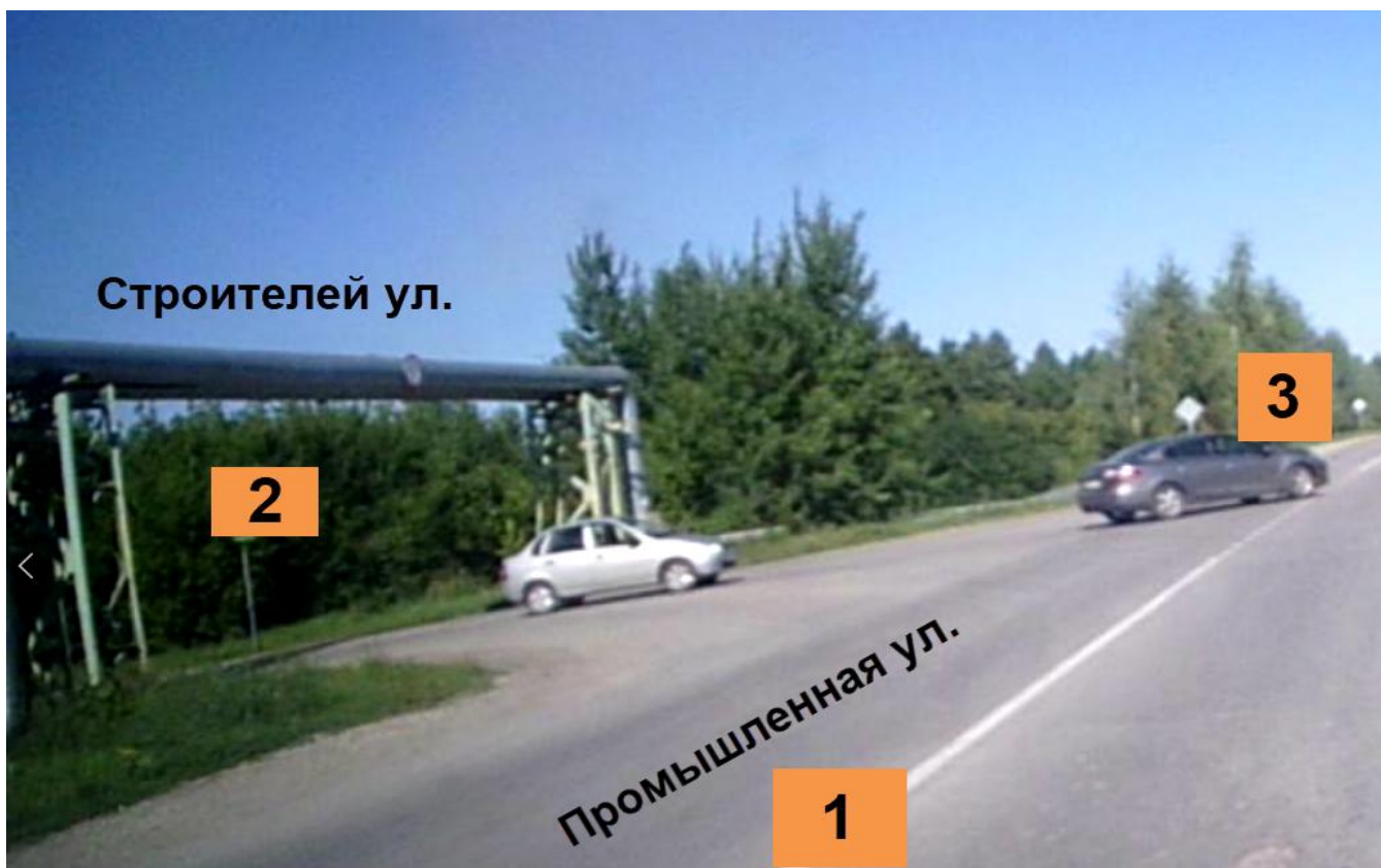
Рисунок А.11 – пересечение автодорог ул. Промышленная – ул. Строителей
